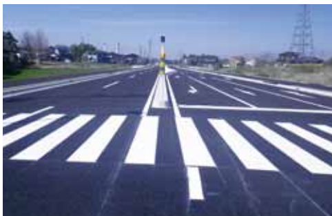
一般国道122号館林明和バイパス
